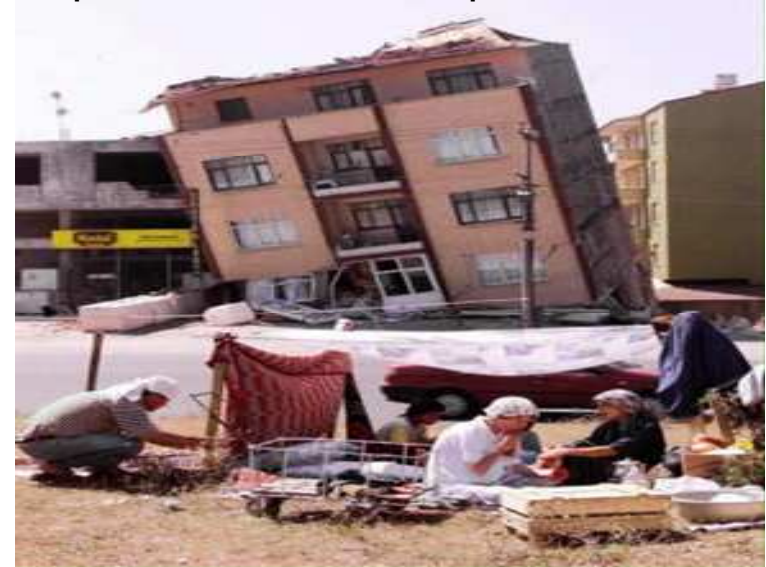
▪ Enfoncement d'un immeuble à cause des phénomènes de liquéfaction
