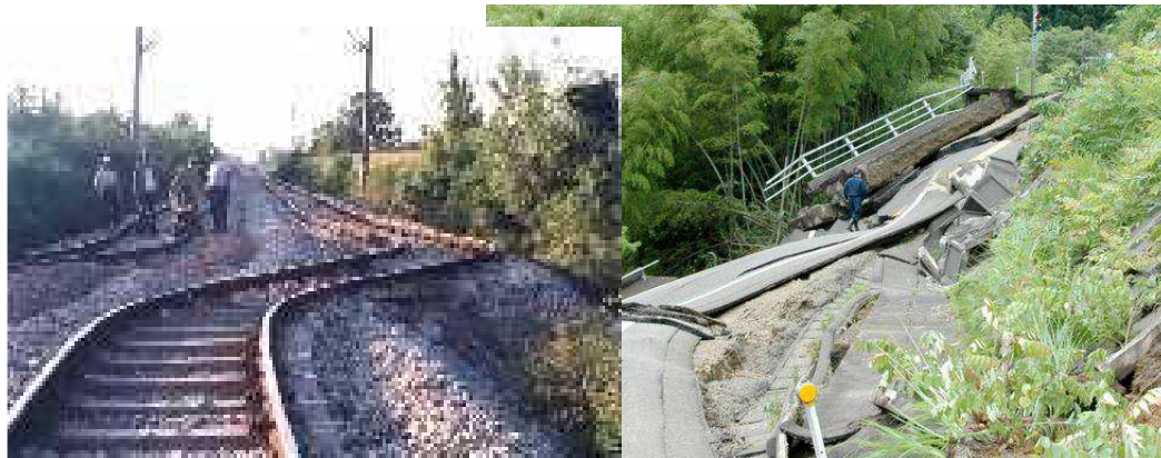
▪ Destructions de infrastructures
